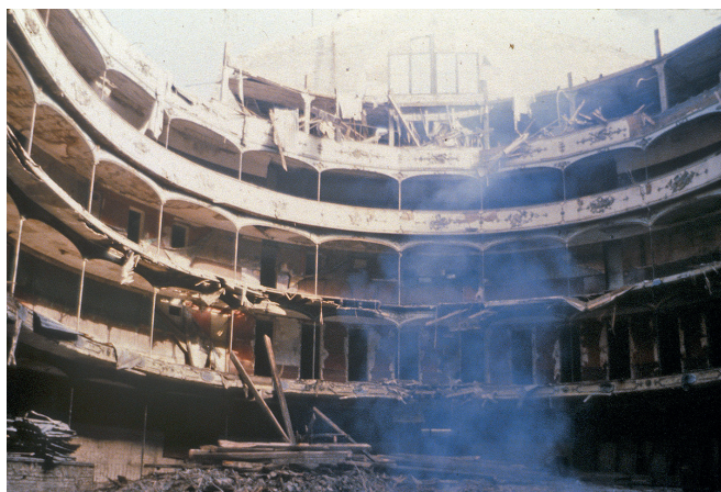
Derribo del Teatro San Fernando en 1973, el más importante y de mayor aforo de la ciudad. Diseñado por los ingenieros Gustavo Steinacher y Pablo Rohault de Fleury, fue inaugurado en 1847. Era el primer edificio de estructura de hierro en Sevilla. Antonio Barrionuevo
